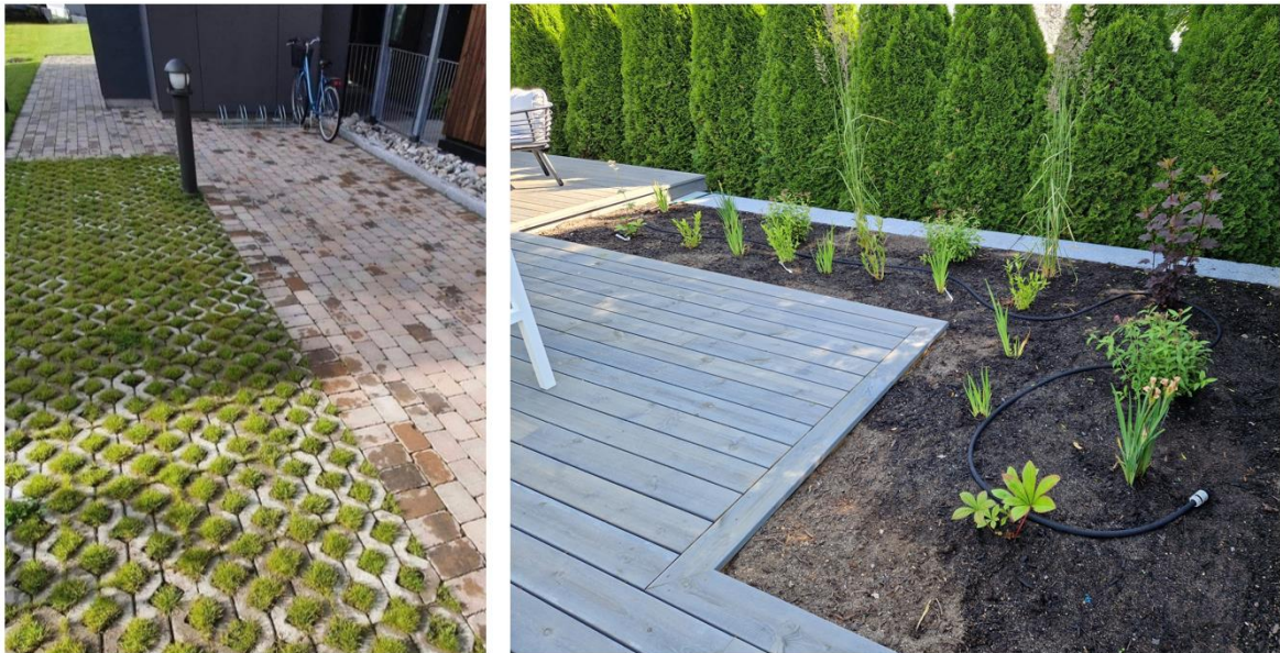
Figur 8 Eksempler på mindre blågrønne løsninger. Bilde til venstre: Gressarmeringsløsning, NorgesJord AS og bilde til høyre: Regnbed i privatbolig, Maskin og Utemiljø AS
