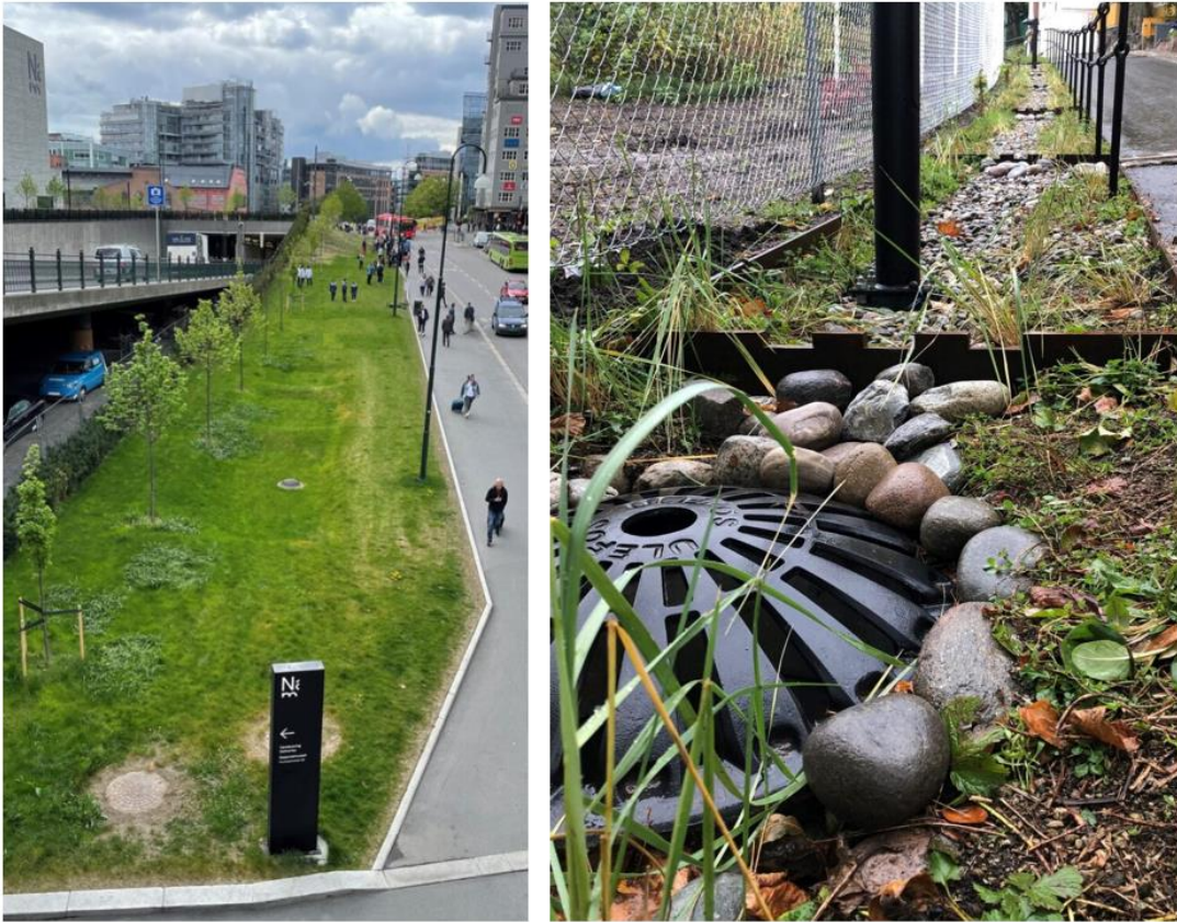
Figur 5 Fordrøyningsareal i Munkedamsveien, Oslo (venstre) og flomvei i Telthusbakken (høyre). Foto: COWI.
